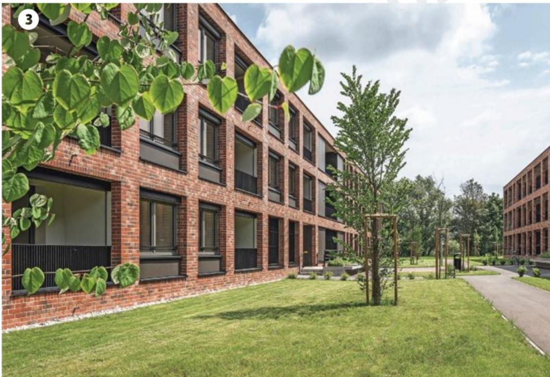
Pet nizkih podolgovatih stanovanjskih stavb s 156 neprofitnimi najemnimi stanovanji ter prostore lokalne skupnosti je zgradil Stanovanjski sklad mestne občine Ljubljana. FOTO BORIS VRANIČ
